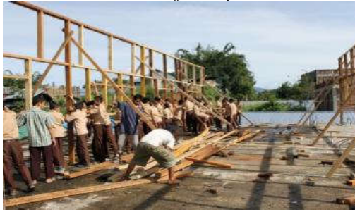
Gambar 6. Renovasi Kampus 1 Semi Permanen Tahun 2012
