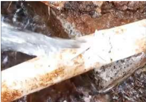
Gambar 2: Kebocoran pipa air yang terjadi di lingkungan perumahan penulis.
